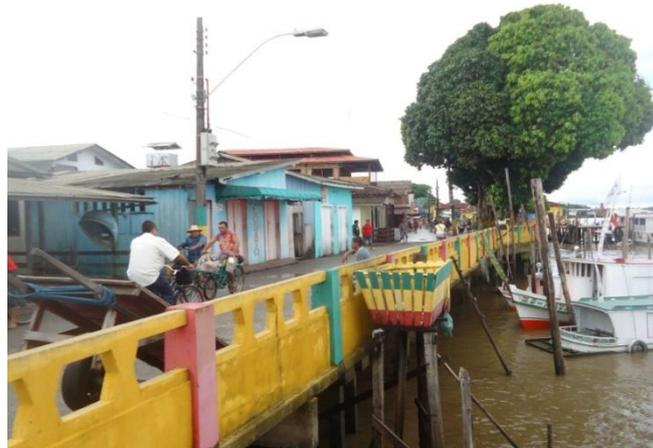
**Figura 3:** Orla de Afuá, ponte em concreto construída sobre palafitas (Foto: Diogo Miranda).
